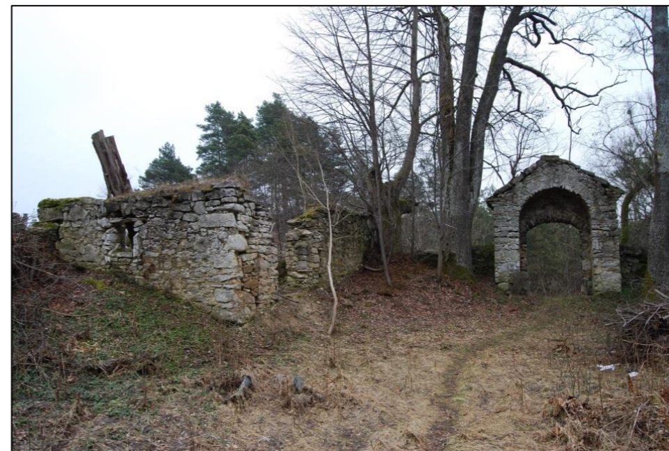
Cerkwisko w Dziewięcierzu Moczarach Pozostałość po cerkwi greckokatolickiej pw. Podniesienia Krzyża Świętego wzniesionej w 1838 r. (fot. T. Brzezińska-Wójcik)
