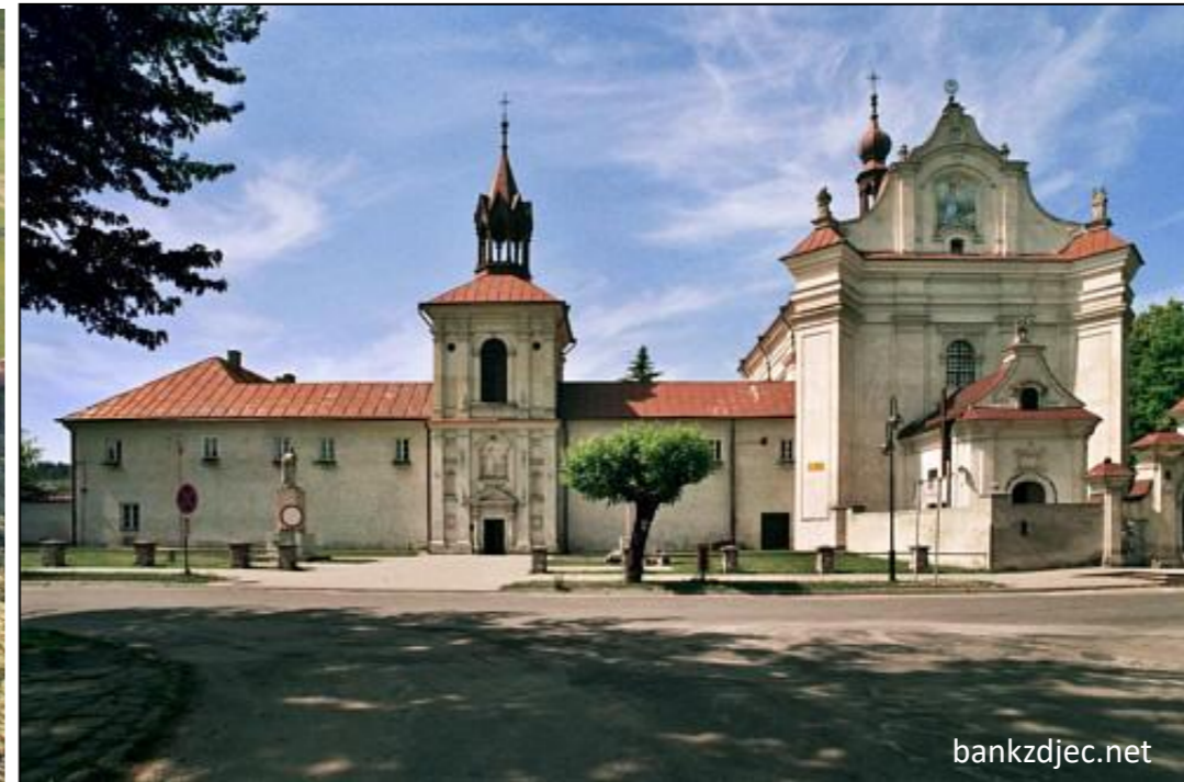
Kościół Nawiedzenia Najświętszej Maryi Panny (1699 r.) i poddominikański klasztor w Krasnobrodzie
